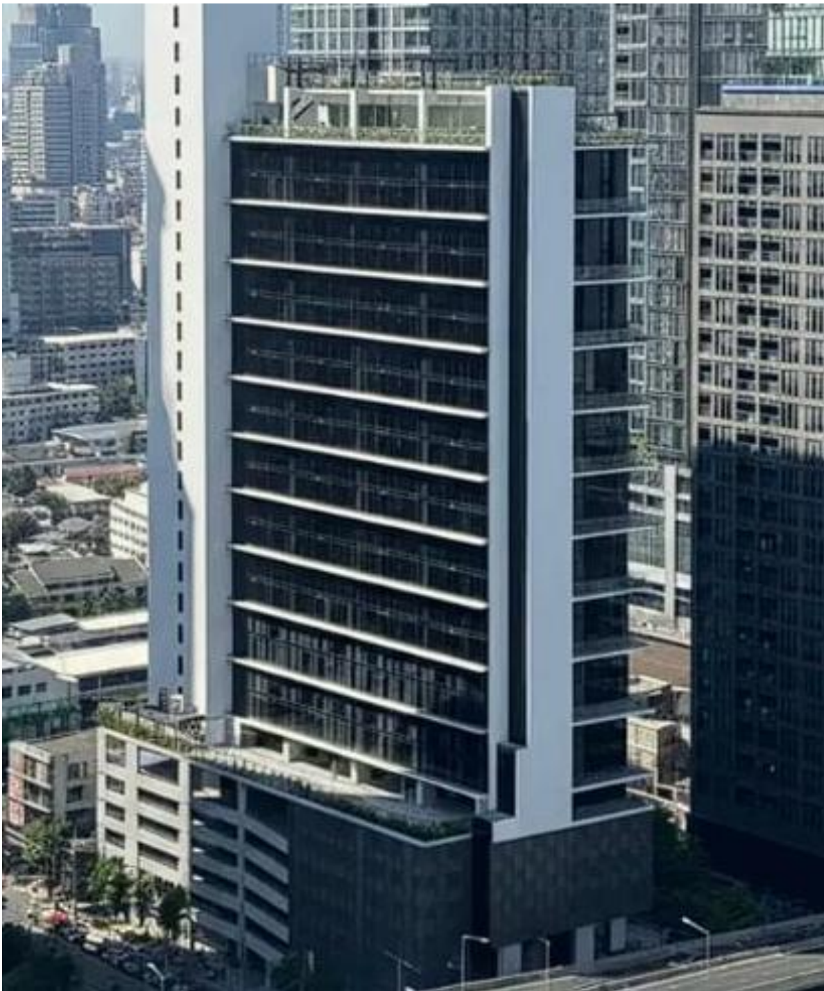
ภาพที่ 1.2-2 สภาพโครงการปัจจุบัน
